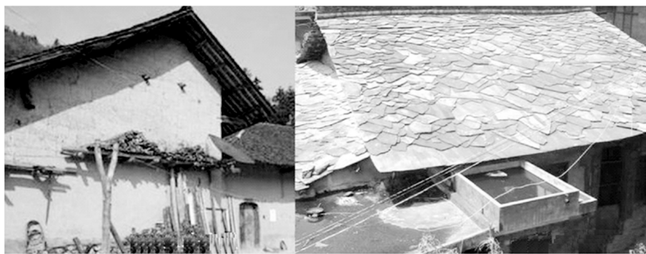
(a) 土墙房屋
